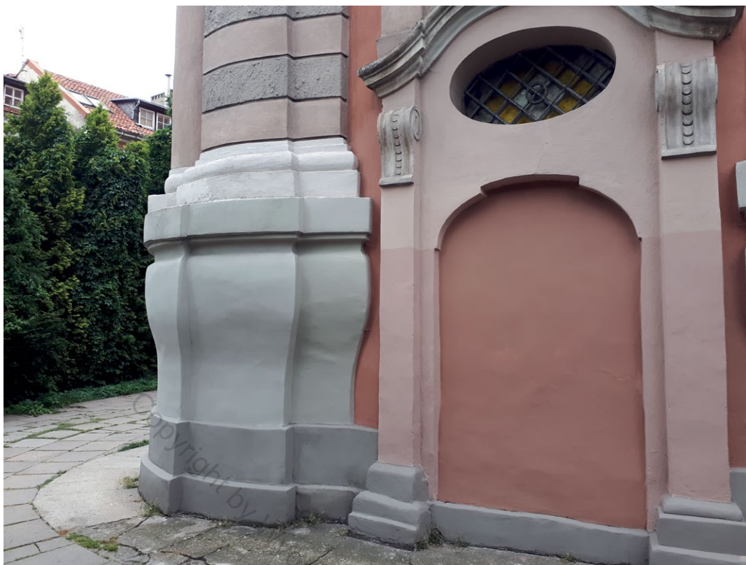
5. Fragm. przyziemia dzwonnicy kościoła Karmelitów Trzewickowych w Wilnie. Fot. Z. Rejewska, 2019 r.
