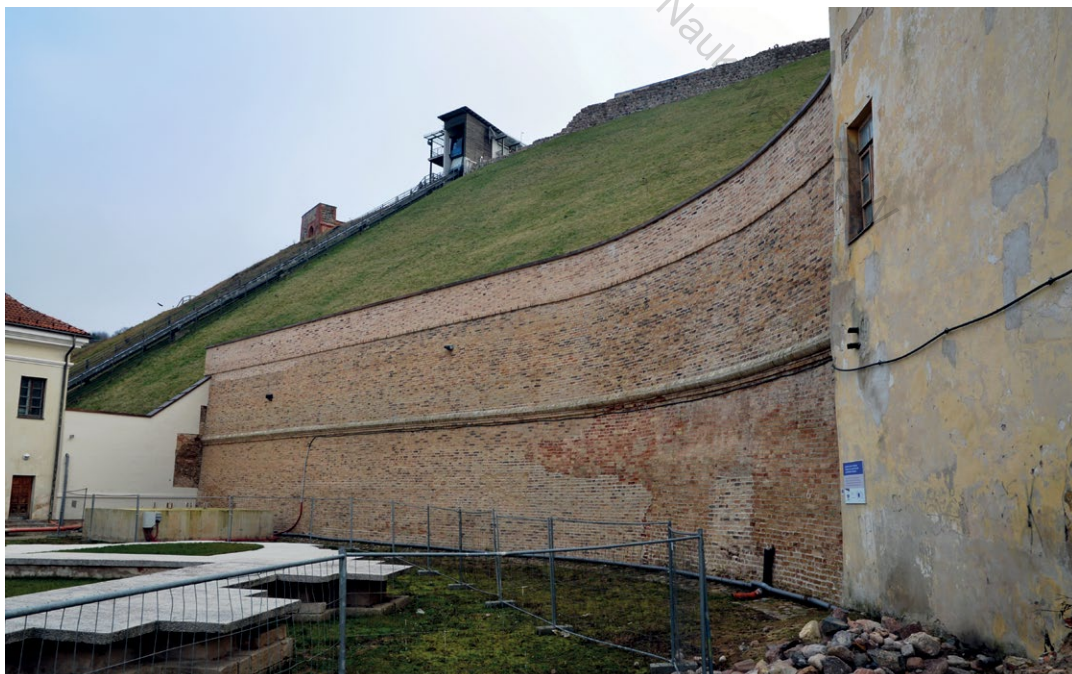
8. Mur oporowy z fortecznym kordonowym wałkiem, wcięty w naturalny stok Góry Giedymina (Zamkowej), wzniesiony w trakcie budowy kościoła pw. św. Anny i św. Barbary, czyli po 1553 r. Z lewej strony fragm. murów świątyni przykryty betonową płytą, za nim fragm. Domu Horodniczego, przystawionego do wcześniejszego odcinka muru oporowego z lat 1544–1546. Fot. K. Guttmejer, 2020 r.
