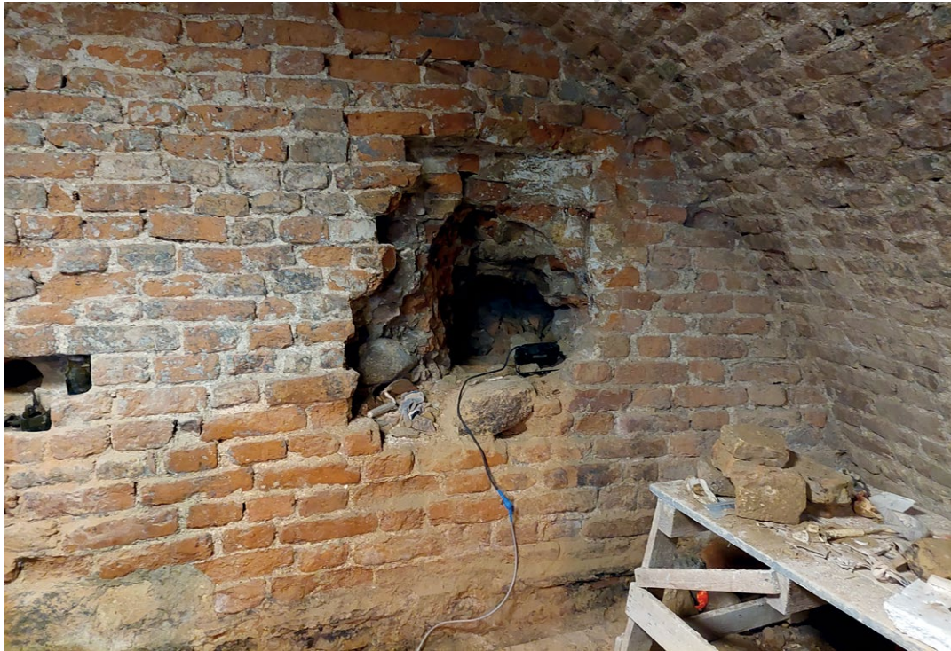
21. Otwór w tylnej ścianie piwnicy P-3 w stronę zbocza góry. Fot. B.R. Vitkauskienė, 2022 r.
