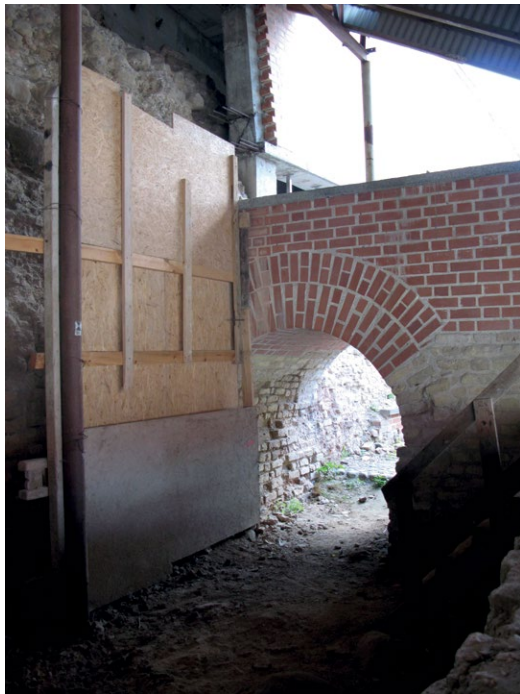
10. Restaurowany fragm. galerii przy ścianie oporowej za pałacem Radziwiłłów.
