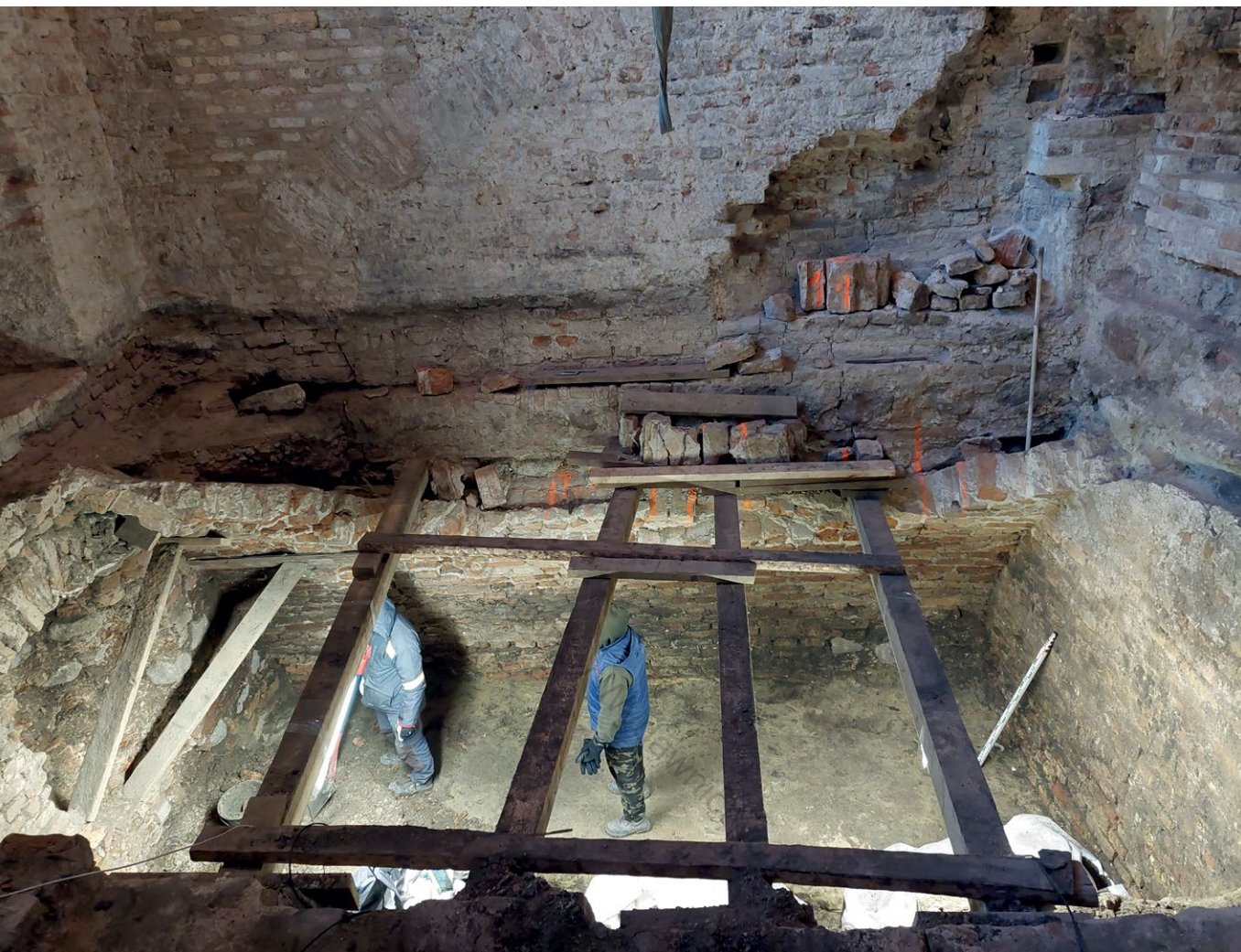
17. Odkopana piwnica P-1 z widocznymi pozostałościami sklepienia. Fot. B.R. Vitkauskienė, styczeń 2022 r.
