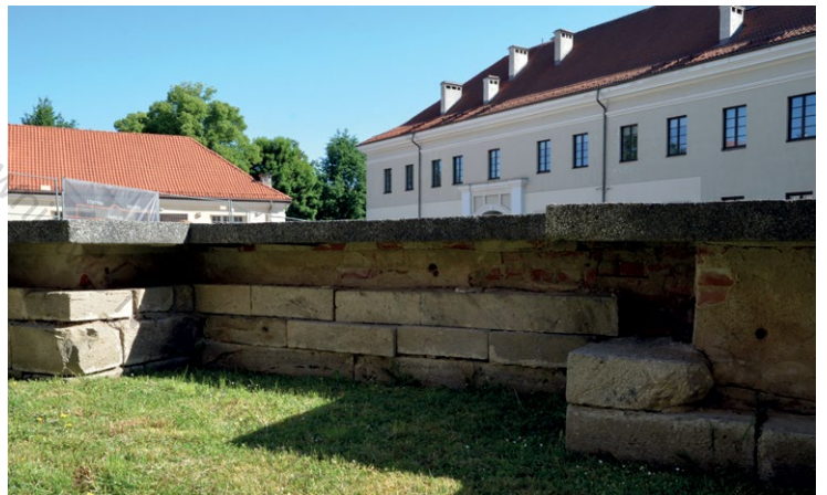
5. Fragm. zachowanego cokołu kościoła pw. św. Anny i św. Barbary od strony południowej, przykryty zabezpieczającą betonową płytą. Fot. K. Guttmejer, 2023 r.
